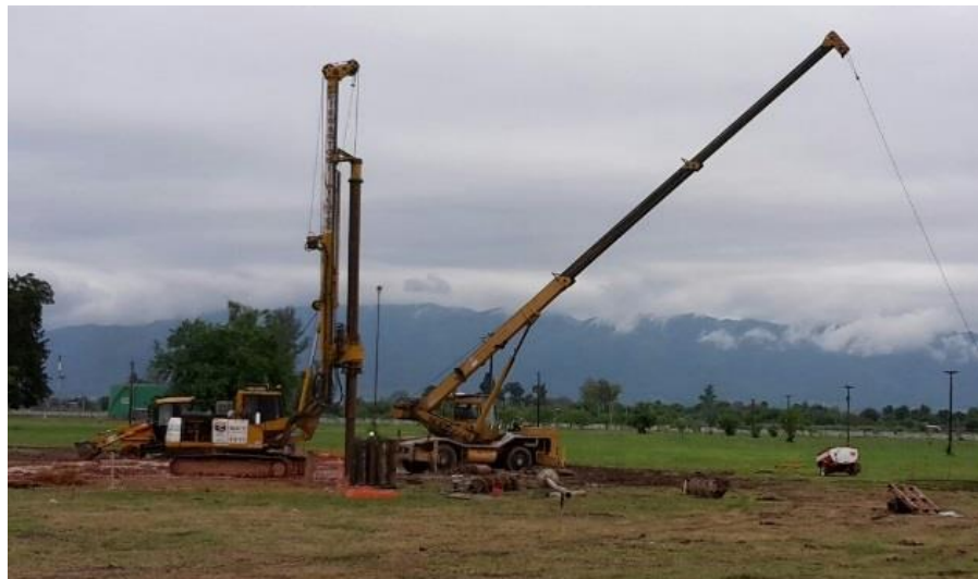
20/10/16 – Ejecución de pilote bases Auxiliares
