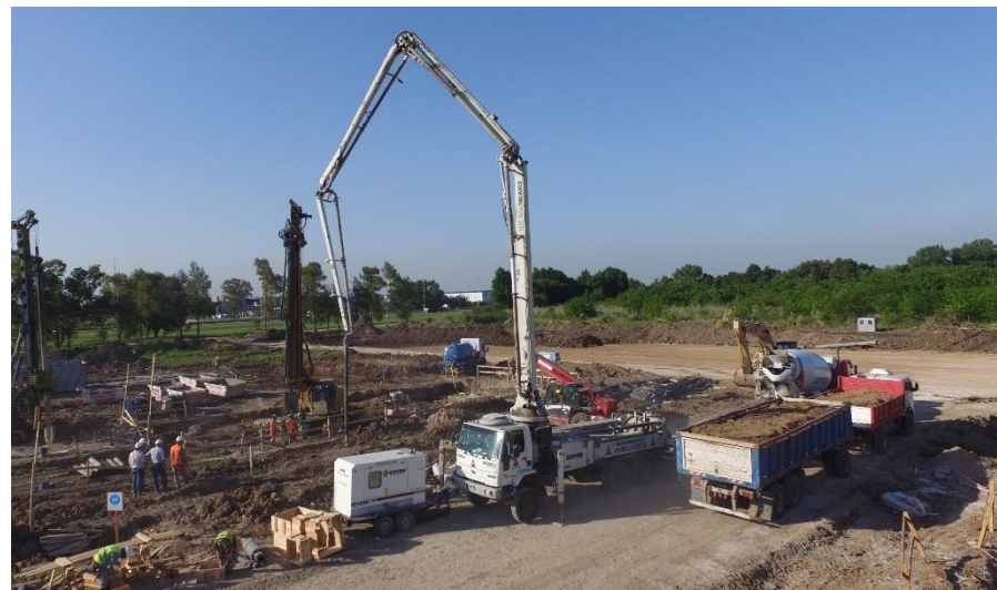
04/11/16 – Ejecución de pilotes para base de las Turbinas
